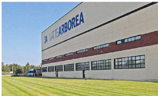
Lo stabilimento della 3A di Arborea
