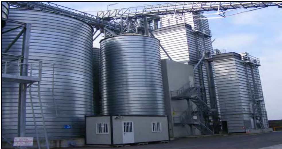
Impianto essiccazione a Iolanda di Savoia (FE)
